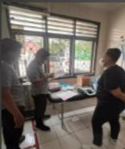
Instalasi dan Uji fungsi Ventilator di RSK. Paru Medan
